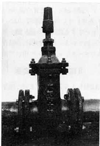
図3.30 仕切弁（制水弁・泥吐弁として使用）
