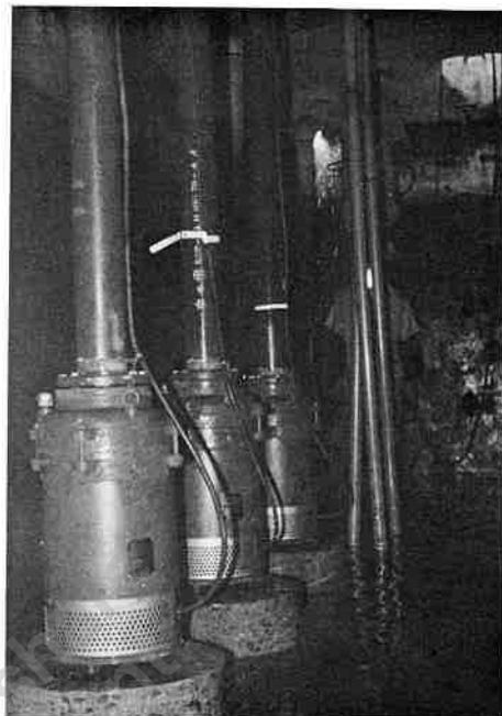
図3.23 貯水槽に設置した水中渦巻ポンプ
